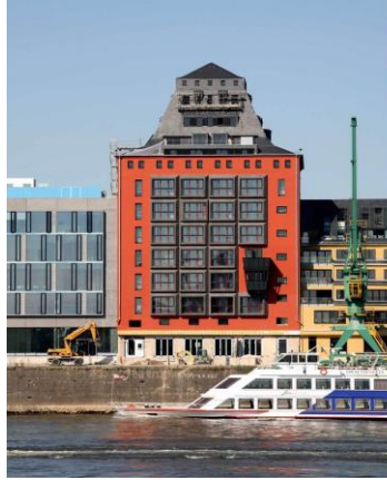
_Silo Haus 26, Köln (AWD Ingenieure)
